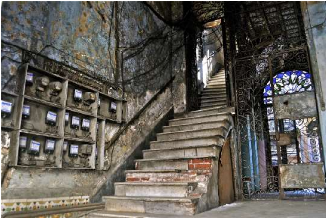
Cage d'escalier - novembre 2011
